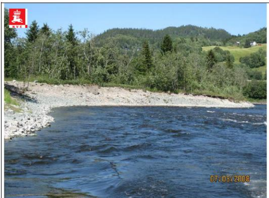
Midtre deler av anlegg som er nylig reparert.
