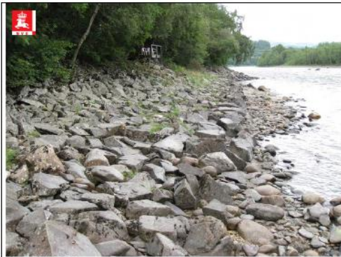
Øvre deler av anlegg
