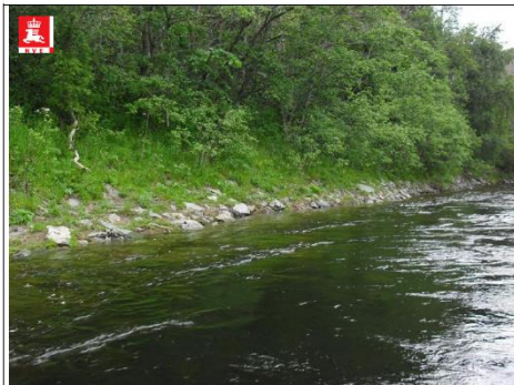
Øvre deler av anlegg.
