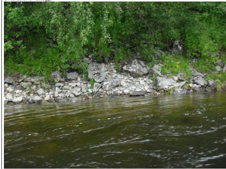
Midtre deler av anlegg.
